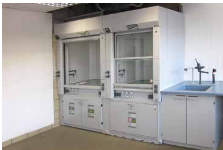
Laborabzüge mit Gefahrsstoffunterschrank und Waschbeckenunterschrank, Tischplatte aus Keramik
